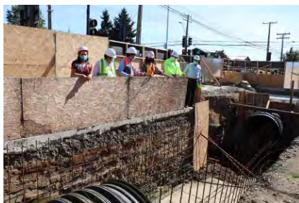
Figura 5. Revisión de proceso de instalación de colector por las autoridades
