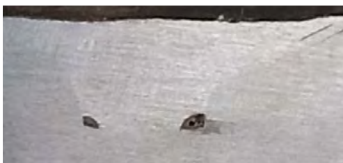
Figura 16. Corte de Cordón de soldadura - Prueba 2
