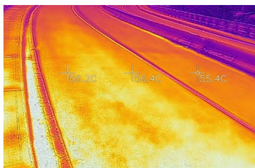
Figura 3. Ejemplo de datos de mediciones en el puente Tizón, Neiva [11]
