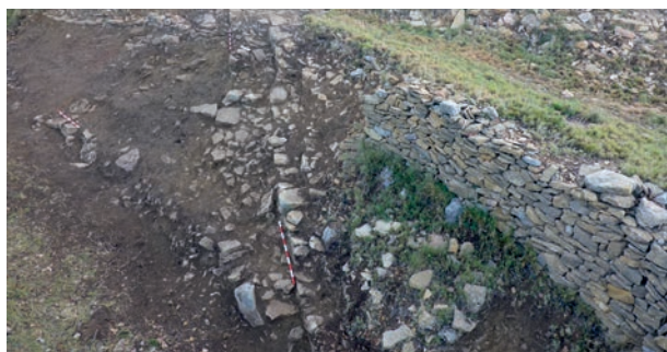
Figura 46. Campaña de 2016. Al desmontar el bancal se pudo ver la continuación del muro UE1060 que forma la cara externa de la Muralla Oeste.
