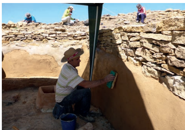
Figura 228. Aplicación de una capa e mortero de cal teñida para proteger la superficie de la roca caliza bioclástica recortada.
