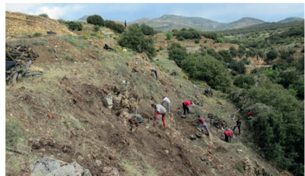
Figura 55. Vista general del desbrozado de la Muralla Este. En la esquina izquierda superior se aprecia el tramo el Muralla Norte.
