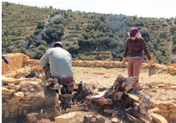
Figura 223. Extracción de las raíces de las carrascas del muro UE1277, sector H25.
