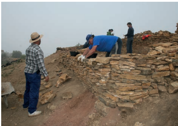
Figura 225. Montaje del muro UE1012, sector H02.
