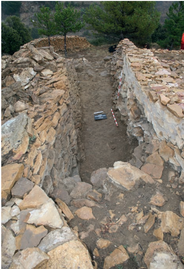
Figura 44. Campaña de 2013. Final de excavación del paso de la Muralla Norte. Se observa a la izquierda el muro UE1094 y a la derecha el muro 1014 por su cara N construido sobre rellenos.
