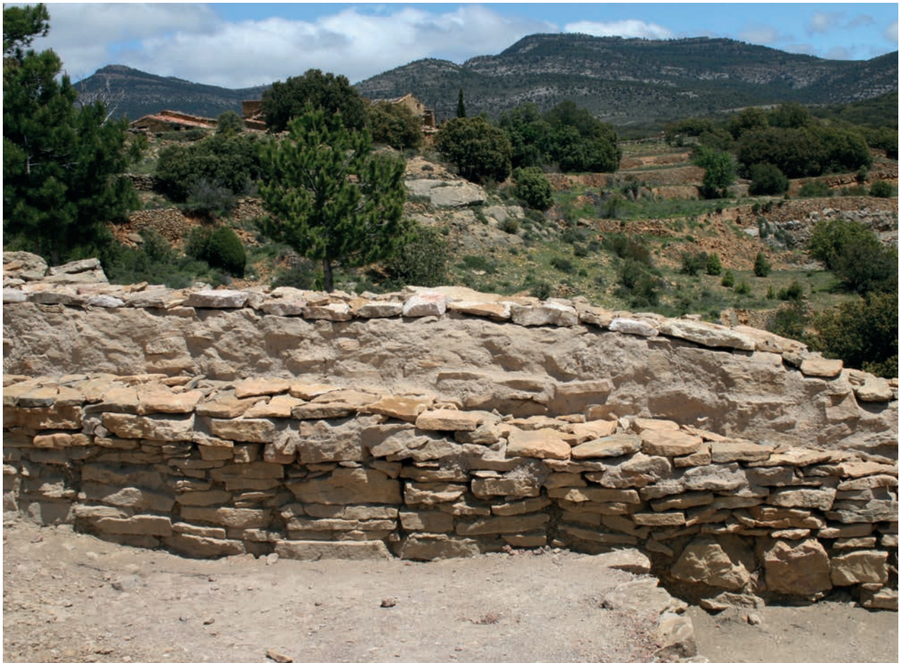
Figura 137. Poyo (UE1022) adosado al muro de cierre norte del sector H01 (UE1014).
