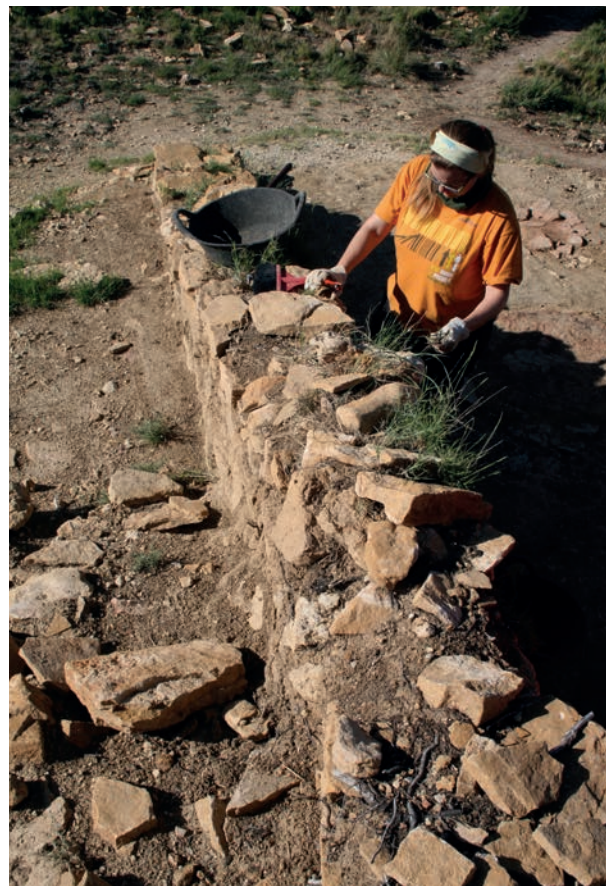
Figura 222. Proceso de limpieza mecánica del muro UE. UE1082, sector H06.
