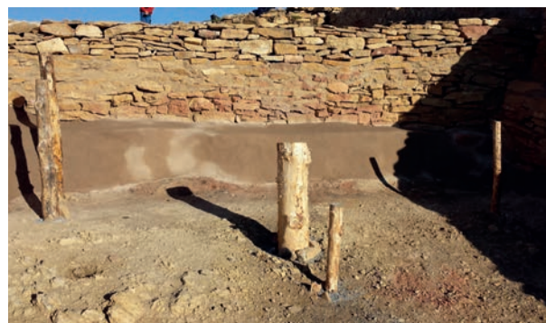
Figura 231. Instalación de troncos en los agujeros de poste del sector H02.
