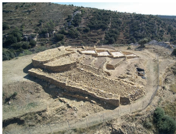
Figura 53. Vista general de la Muralla Oeste después de su consolidación.
