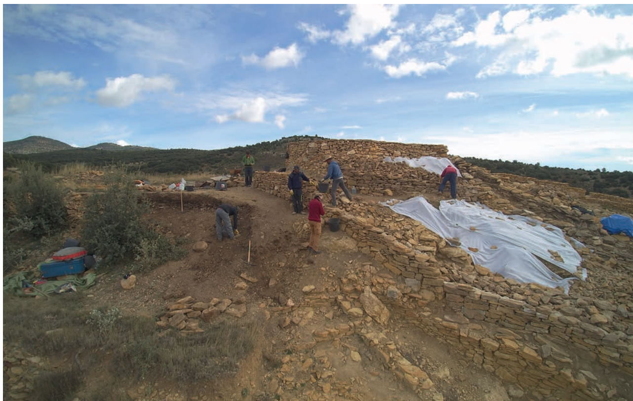
Figura 233. Proceso de consolidación de las estructuras del sistema defensivo, Muralla Oeste.
