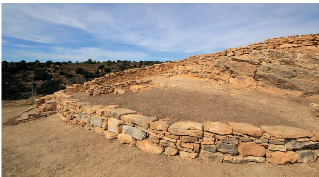
Figura 235. Rampa situada al extremo sur del poblado para acondicionar el acceso a la zona superior.
