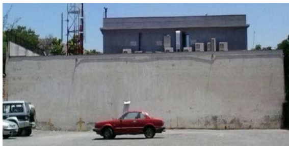
Figura 1. Muro de estacionamiento, cedido por el ayuntamiento para la realización del mural sambernardino. (Ruddy Zúñiga, 2013)
