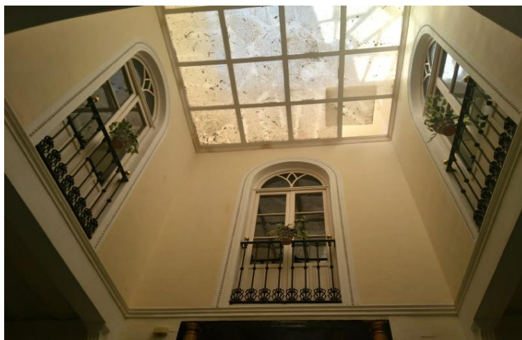
Fig. 10: Detalle de la montera de vivienda en calle Nicolás Megía.
