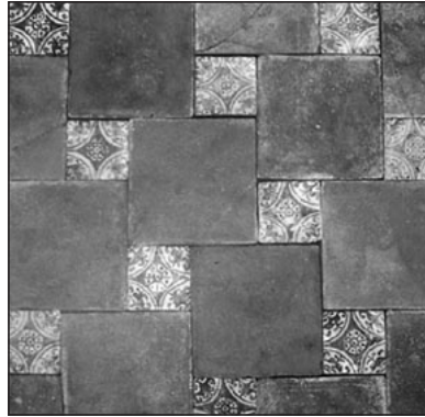
Fig. 11. Imagen publicada por Mesquida (2001) del pavimento de la Sala B, Casa I de Paterna, donde se combinan azulejos de estrella con baldosas bizcochadas más grandes.
