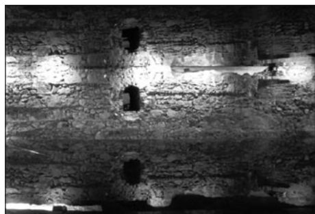
Fig. 8. Muralla de la plaza de la Marina (Málaga). Intervención.
