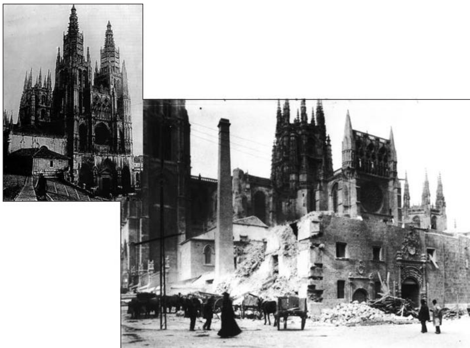
Fig. 1. Catedral de Burgos. Derribo del Palacio Episcopal, 1915. (Archivo Municipal de Burgos)
