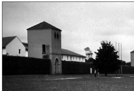
Fig. 4. Colonia Ulpia Traiana (Xanten). Recinto y torres de la muralla.
