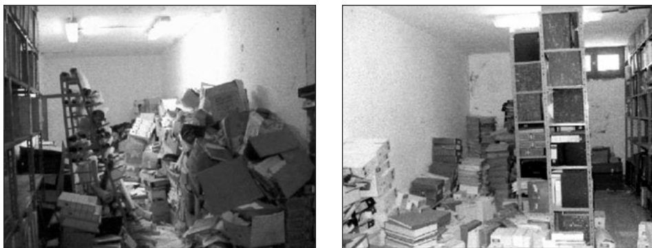
Fig. 1. Imágenes del estado del Archivo Municipal de San Bartolomé de Tirajana en octubre de 2001.
