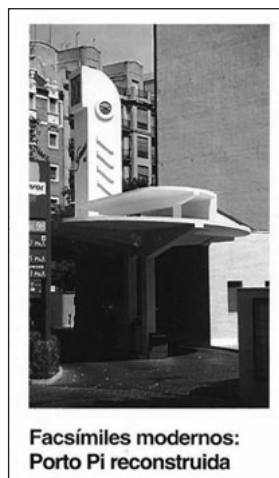
Fig. 3. Reconstrucción de la Gasolinera Porto Pi. Foto reproducida en la revista Arquitectura Viva , n° 50, 1996. Foto de la autora
