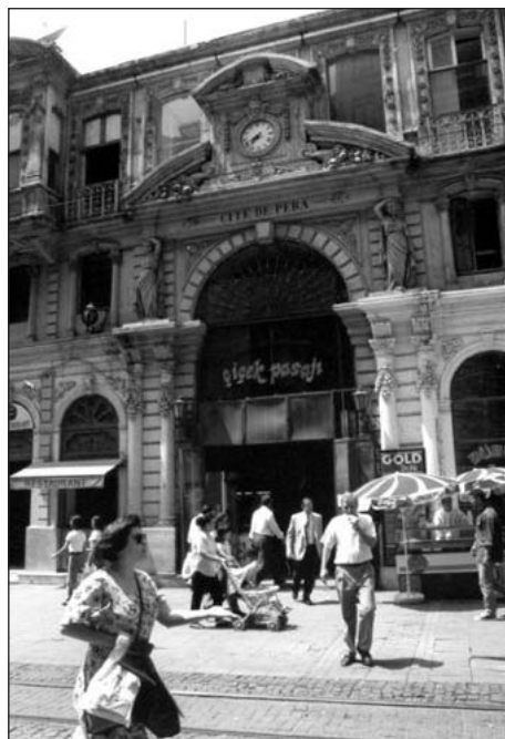
Fig. 3. Fachada a la Gran Vía del edificio de la Cité de Pera o Çiçek Pasajı .
