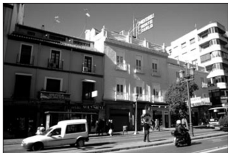
Fig.2. Casa familiar Acera del Darro, 46 (Granada). Fachada e implantación urbana.
