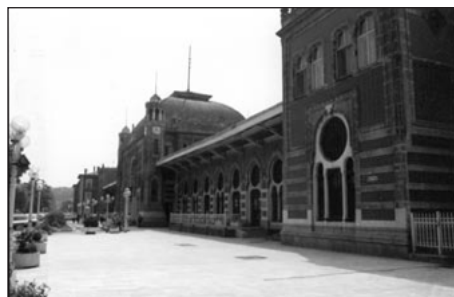
Fig.2. Fachada principal de la estación de Sirkeci.
