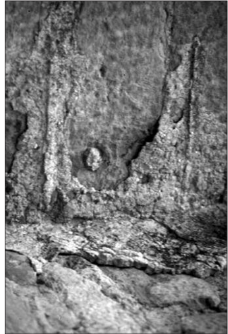
Fig. 4. Oviedo. Iglesia de San Julián de los Prados. Contrafuerte del ábside. Detalle del revoco.
