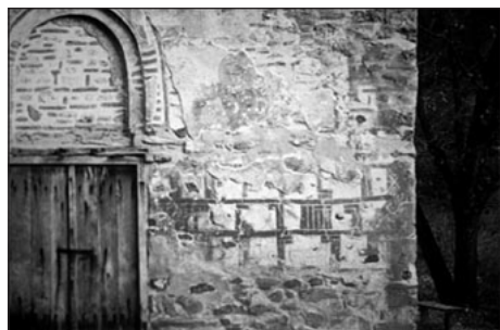
Fig. 5. Kurbinovo (Macedonia). Iglesia de San Jorge. Fachada principal. Detalle del revoco decorativo.
