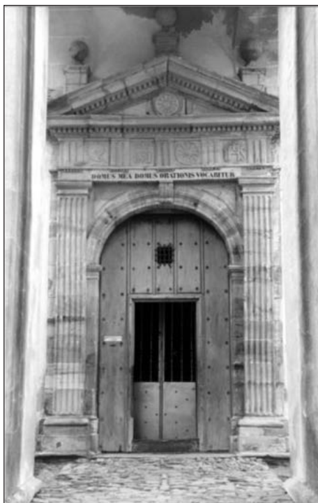
Fig. 6. Portada de la iglesia de Conforto. A Pontenova (Lugo).
