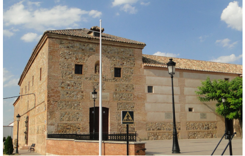
Ilustración 2. Convento de San José de Malagón
