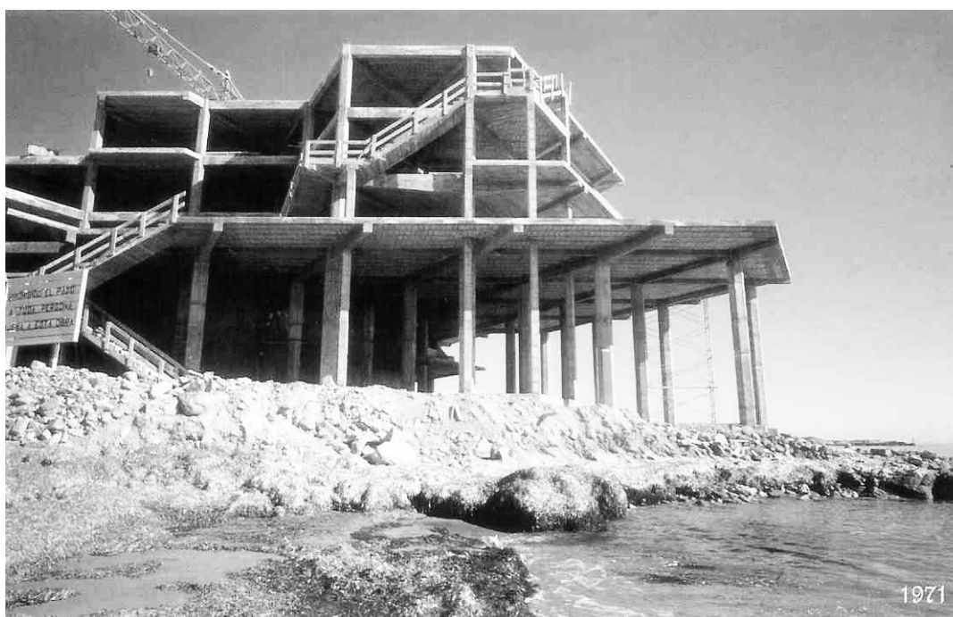
Fig.9. Fotografía de 1971, estado en estructura de la construcción del Club Náutico de la Dehesa de Campoamor. Fuente: Empresa Sudecasa -Servicios de Urbanización Dehesa de Campoamor-
