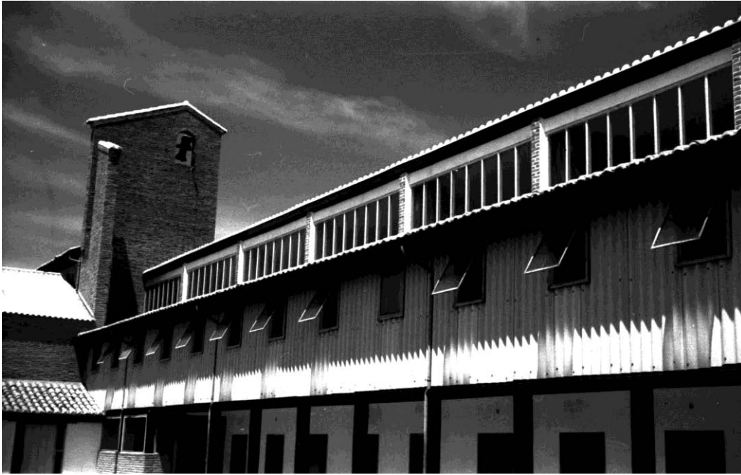
Vista de los dormitorios desde el exterior.
