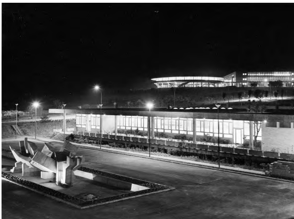
(Fig. 9). UL de Cheste : Plaza principal de acceso con escultura-fuente en hormigón armado de Javier Clavo © AP-CTAV
