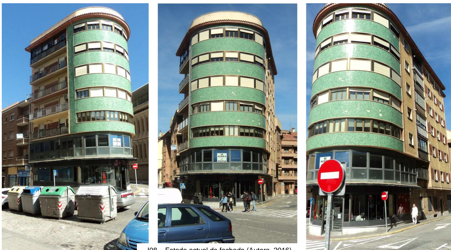
I08 – Estado actual de fachada (Autora, 2016)
