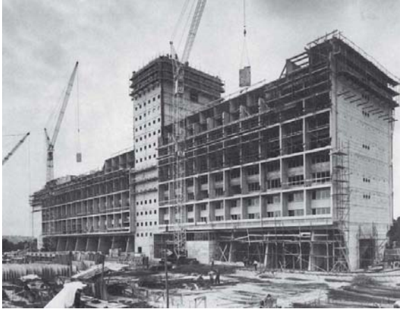
Unite d'Habitation, Le Corbusier, 1952, Marseilla Fuente: FLC Paris
