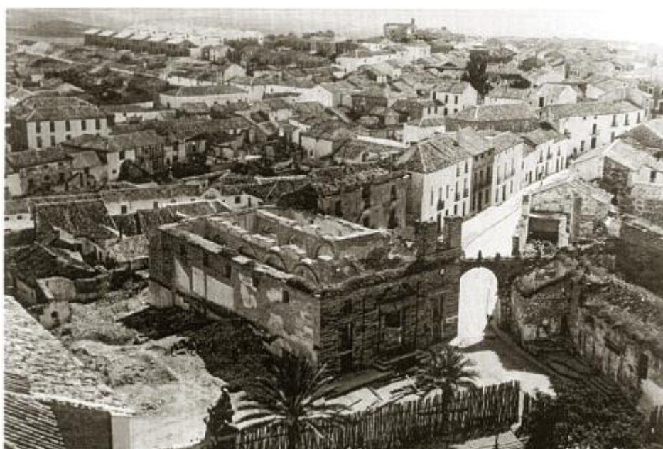
Estado en que quedó el edificio del Ayuntamiento tras la Guerra Civil previo a la intervención de Ramón Pajares.
