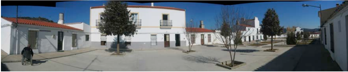
Figura 13. Plaza Núñez de Balboa desde su acceso norte. En el centro una vivienda tipo A-3 que ha incrementado su altura con una planta adicional. A la derecha la agrupación de viviendas B-5, B-4.
