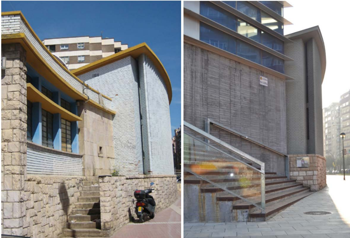
(Fig. 9) Parte de la fachada del edificio a la Avenida de Navarra, antes y después de la ampliación. Fotografía del Archivo del Servicio de Patrimonio del Ayuntamiento de Zaragoza y fotografía de la autora.
