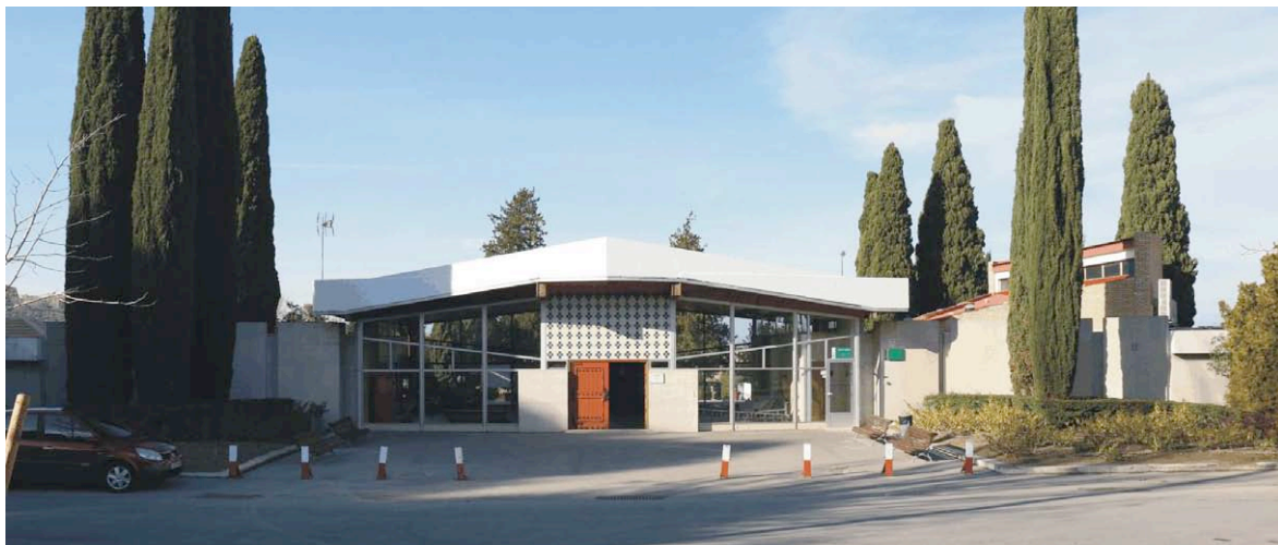
Fig 4. Estado actual de la entrada al Nuevo Cementerio Municipal de Jaén. Fotografía del autor.
