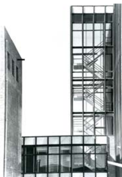
Fig.04 Zona del patio peatonal de acceso a la zona de maquinaria. No se conservan fotos del patio a nivel de pavimento en el fondo Alas-Casariego de la Fundación Coam, ni aparecen en las publicaciones consultadas. Fuente: Informes de la Construcción.
