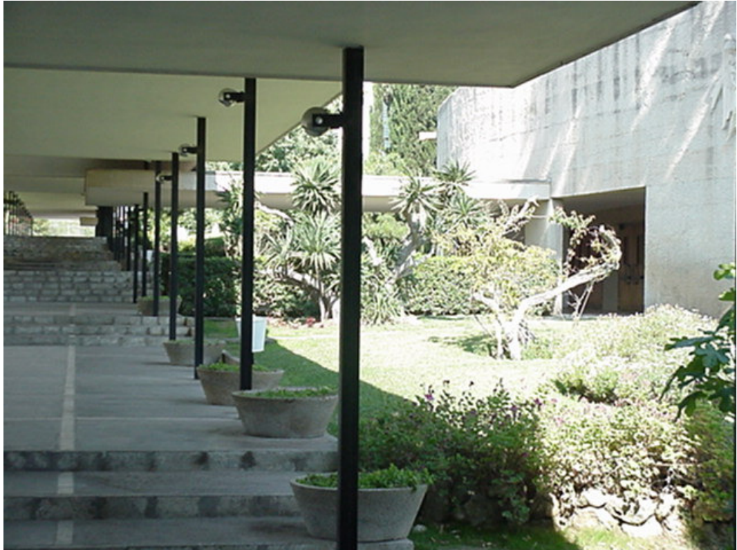
Foto 09. Pasillo e Iglesia (a la derecha).
