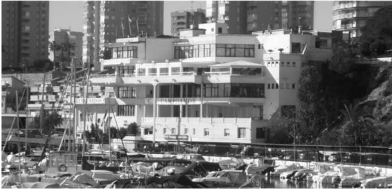
Fig.5. Fachadas a flanco poniente y mediodía del edificio. Fotografía de la autora, estado actual
