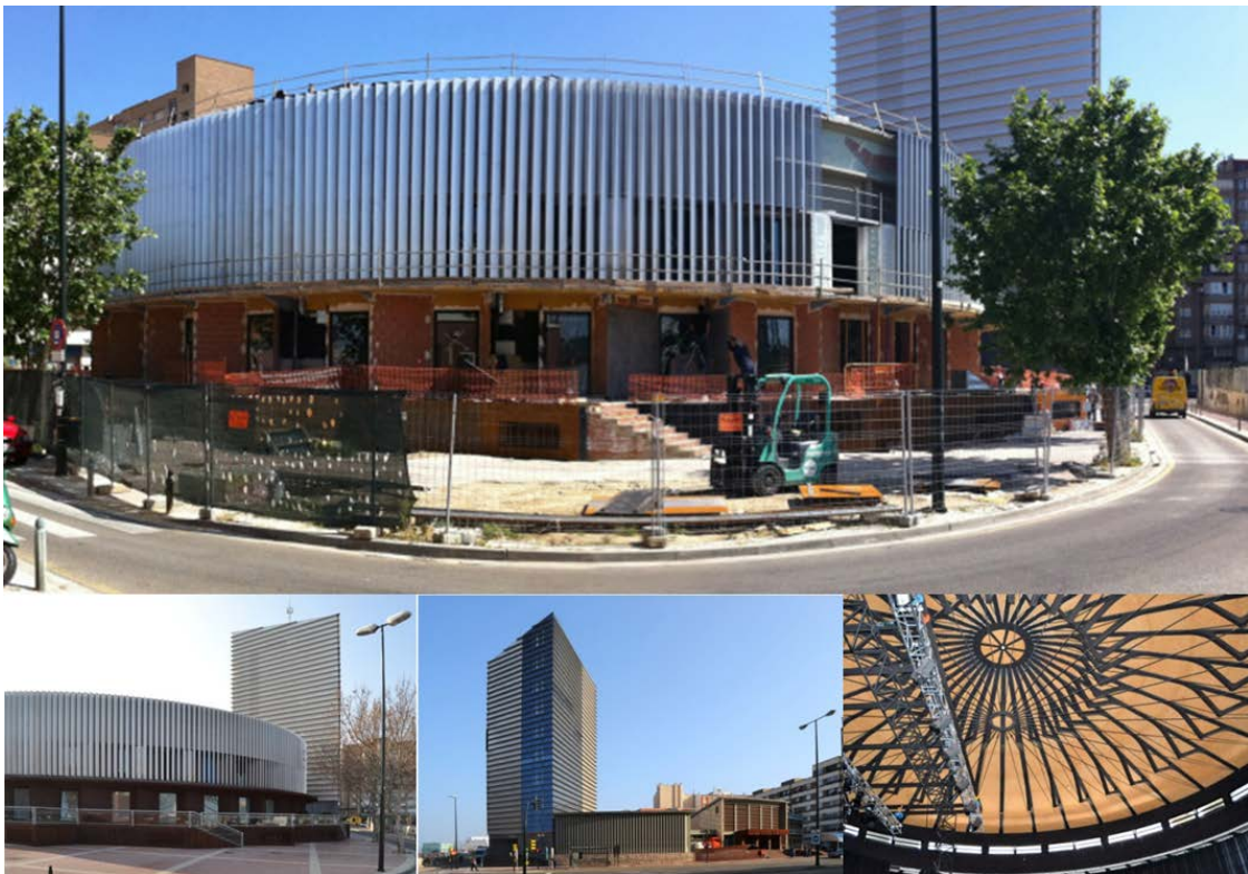
(Fig. 8) Durante el proceso de construcción de las nueva envolvente del Mercado y las obras acabadas. https://cerrejonarquitectos.files.wordpress.com/2011/05/1a-foto8.jpg y fotografías de la autora.
