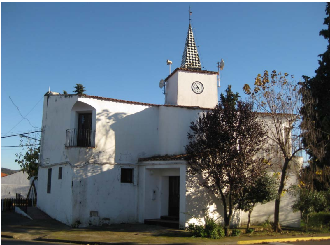
Fig. 10. Estado actual Ayuntamiento (2015)
