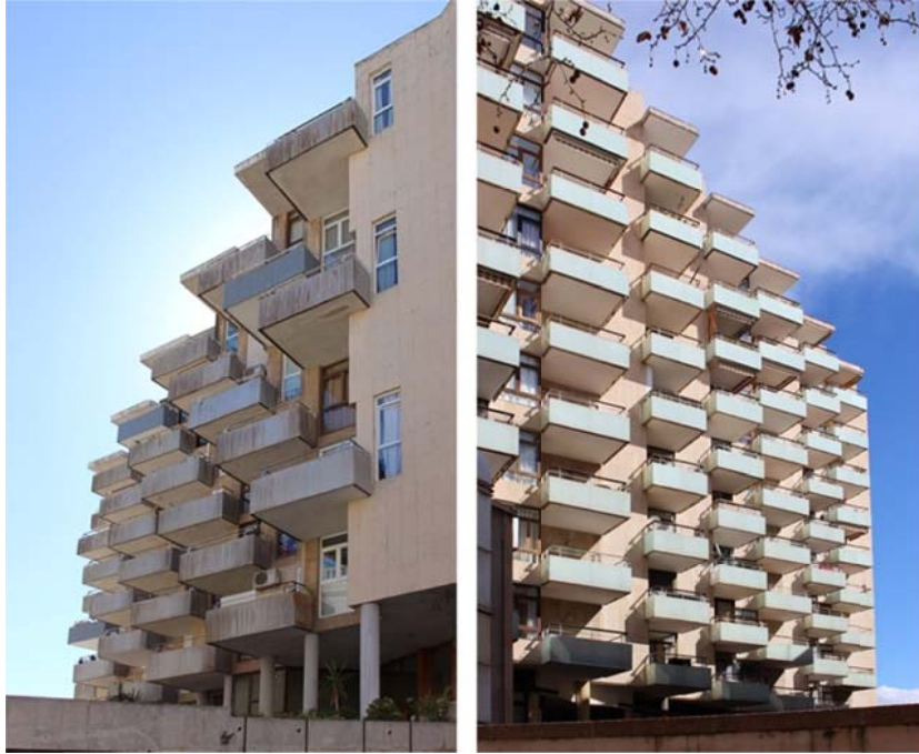
Fig.9. (Izquierda) Detalle de los balcones del edificio La Caleta , María Sebastián, 2016. (Derecha) Detalle de los balcones del edificio Torremar , María Sebastián, 2016.
