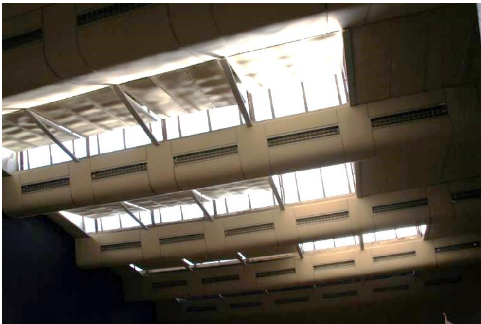
Fig. 4 Cubiertas del Salón de Actos
