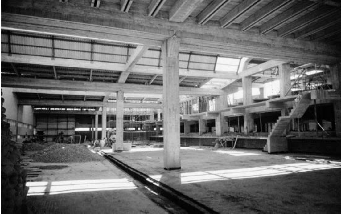
Fig. 6 Imagen de la obra en la nave de lavado en la que aparecen los pilares intermedios.
