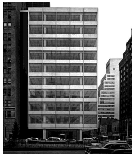
G.Bunschaf (S.O.M.): sede de Pepsi-Cola Co. (1956-60). Fachada hacia Park Avenue.
