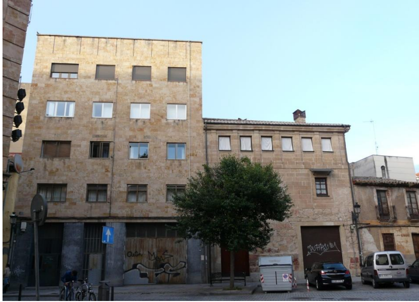
Fig.3: vista de la fachada principal y del edificio colindante (Milena Crespo, 2015)
