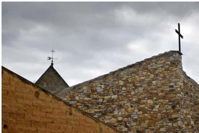
Fig 8. Imagen con los tres tiempos arquitectura de adobe, espadaña original y aparejo de la iglesia contemporánea. Foto Alex del Río.
