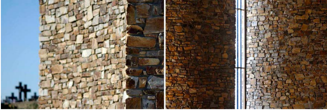
Fig 5. Aparejo de los muros visto desde el interior y exterior del templo. Fotos Alex del Río. Según testimonio del propio Fisac " es el muro de piedra más bonito que he hecho, por supuesto...Estaba hecho como yo les había dicho pero con la gracia ingenua de los que hacen aquello..."
