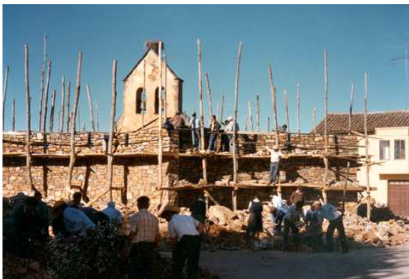
Fig 2. Facendera a pleno rendimiento, verano de 1984. Todo el pueblo organizado levanta los muros de piedra, los andamios fueron realizados con chopos de bosques comunales. Una cadena humana distribuye los bloques y el mortero a la línea de crecimiento del muro.
