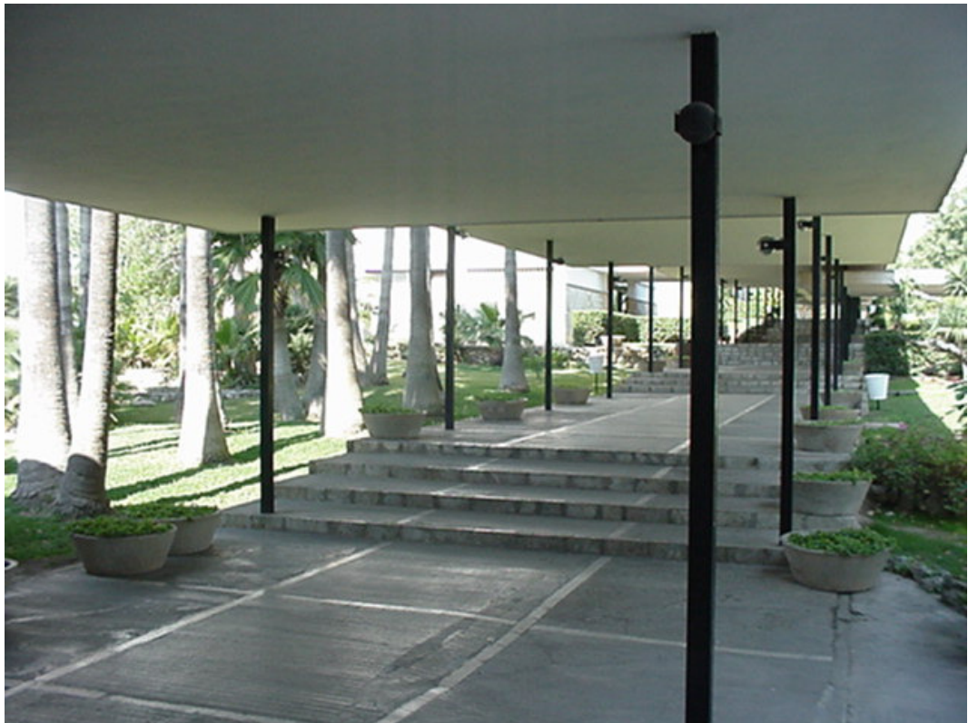
Foto 07. Pasillo o cinta peatonal (frente a la Iglesia).
