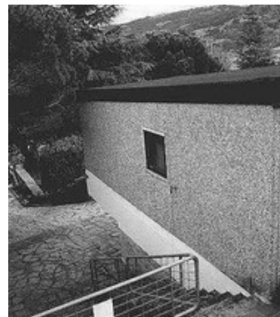
Figura 10: Fachada de panel prefabricado “vuela” Fuente: Fotografía del autor
