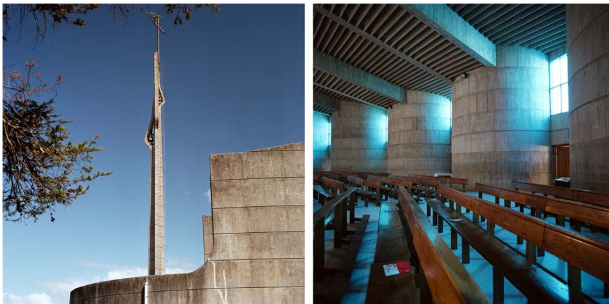
(Fig. 9) La torre-campanario y los muros acústicos de la nave. Obsérvese el color azul de los vidrios (2007). Vari Caramés.
