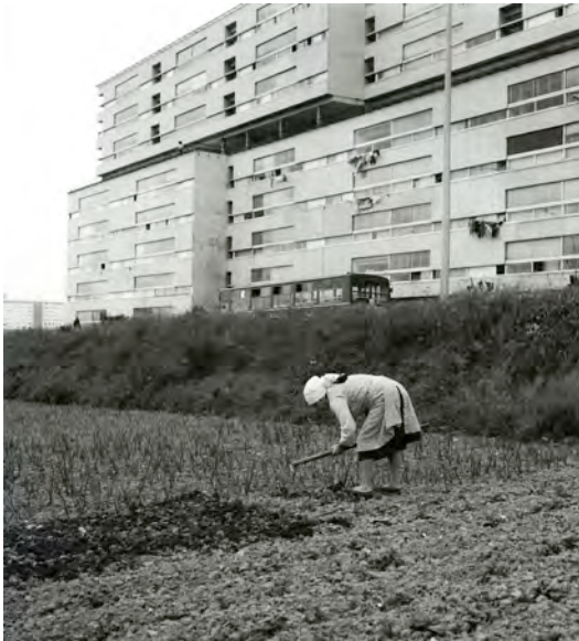
Ilustración 4. Fachada Sur de la Unidad Vecinal n3
