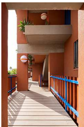
08. Calles elevadas en Santa Águeda donde se puede apreciar el hormigón visto de los forjados (L. Casals, 2014)
