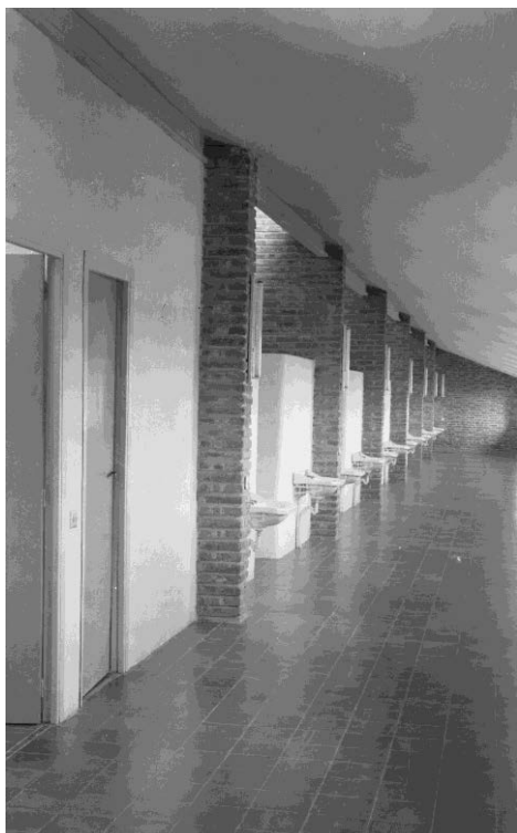
Galería de acceso a los dormitorios.
