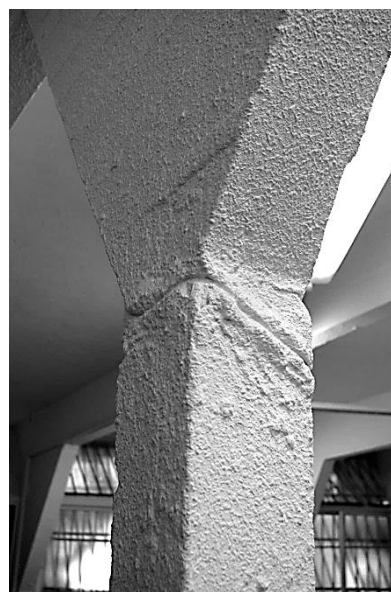
(Fig.7) Esquema de encofrado de viga de canto con cruceta de arriostramiento ( http://www.elconstructorcivil.com ) Detalle del encuentro del pilar y cartelas de hormigón. Su junta. Febrero 2016 (Fotografía propia)
