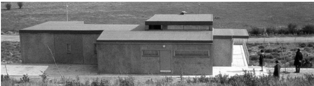
Figura 2: Vista general desde el noroeste recién terminada años 60 Fuente: Fundación Alejandro de la Sota
