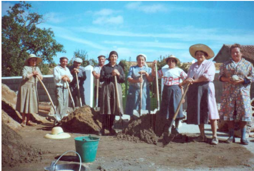
Fig 6. Las mujeres hacían la masa a mano utilizando el agua del canal que atraviesa parte del pueblo hoy en día canalizado, todo realizado a mano por prestación personal.
