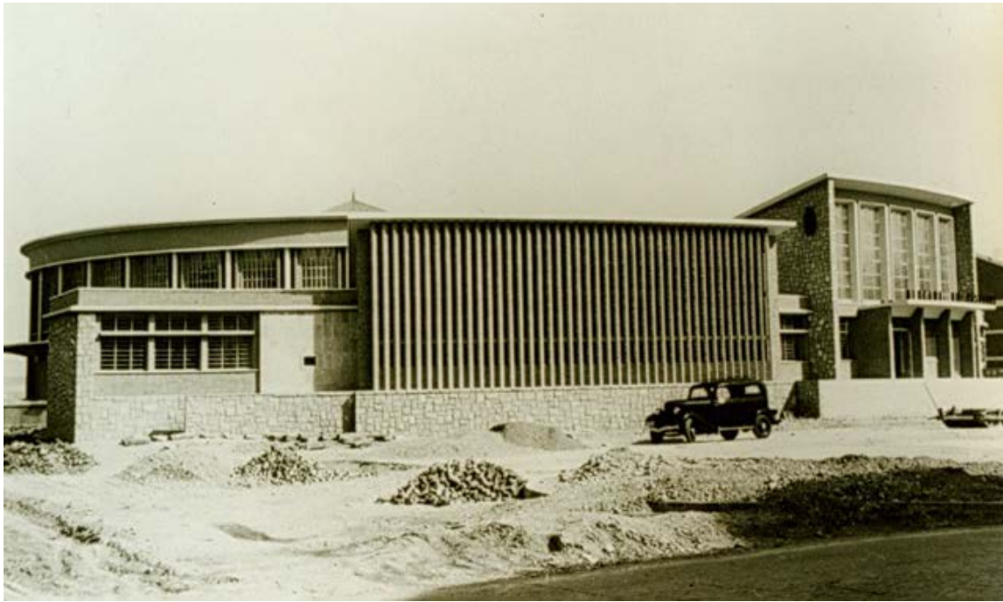
(Fig. 4) El edificio, poco antes de su inauguración. Archivo del Servicio de Patrimonio del Ayuntamiento de Zaragoza.
