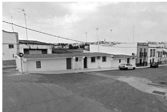
F.7 Microescuelas de Aguilar de la Frontera convertidas en viviendas (Google earth)
