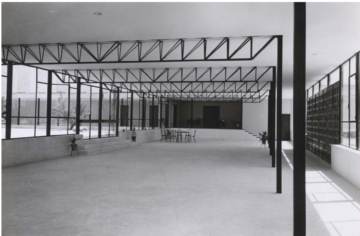
(Fig. 5) Seminario de Castellón. Vestíbulo principal. Legado Luis Cubillo. Servicio Histórico COAM
