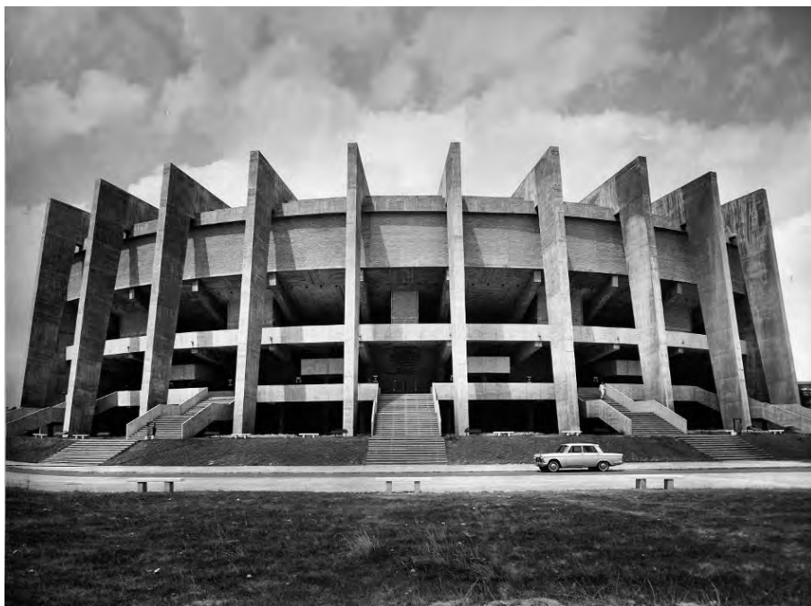
(Fig. 10). UL de Cheste : Fachada principal del paraninfo en su estado original con las circulaciones al aire libre. © AP-CTAV
