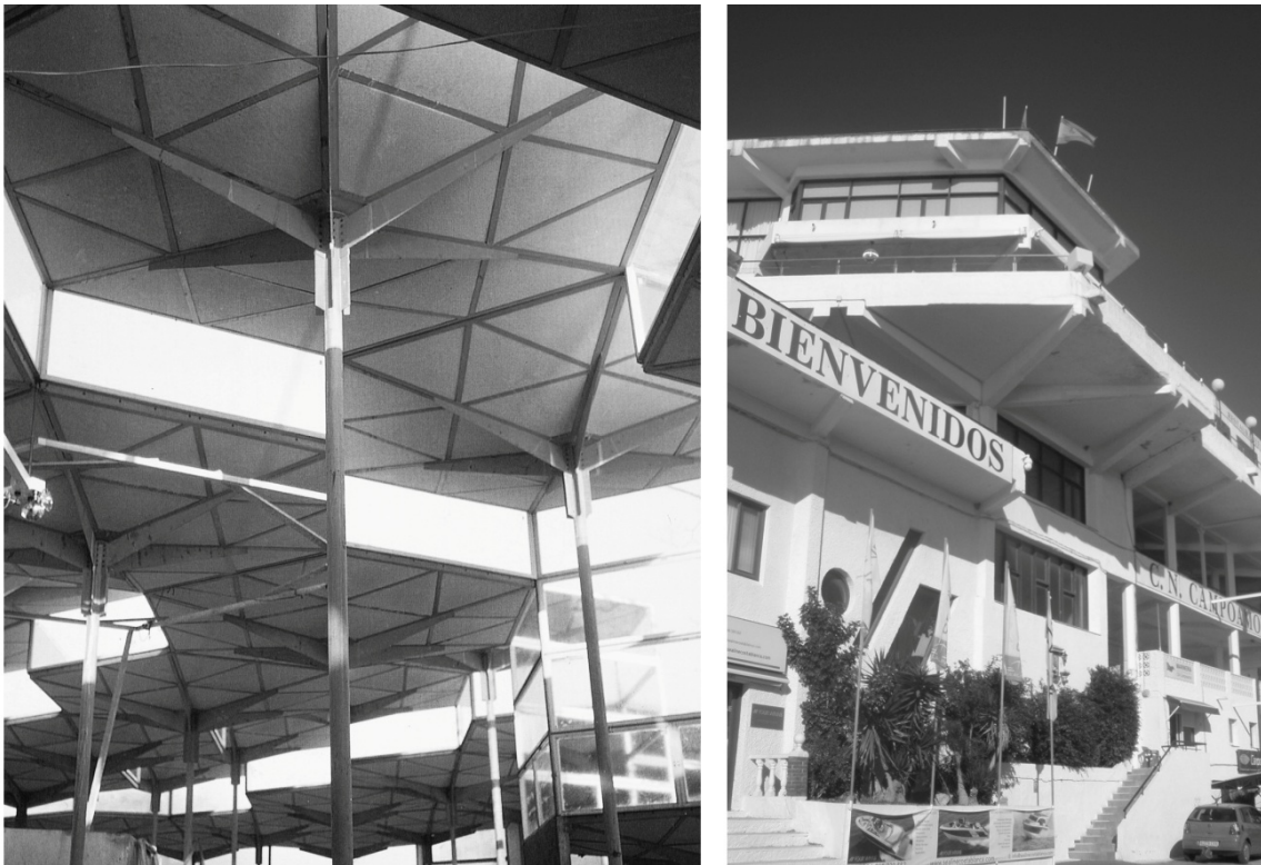
Fig.10. Fotografía del sistema estructural del Pabellón de Exposición de Bruselas de José Antonio Corrales y Ramón Vázquez Molezún emplazado tras su traslado en la Feria del Campo de Madrid, y reformado 1968 por Fernández del Amo. Fotografía del estado actual de Club Náutico de Campoamor con vigas de canto de hormigón sustentado terrazas en voladizo. Fotografía de la autora
