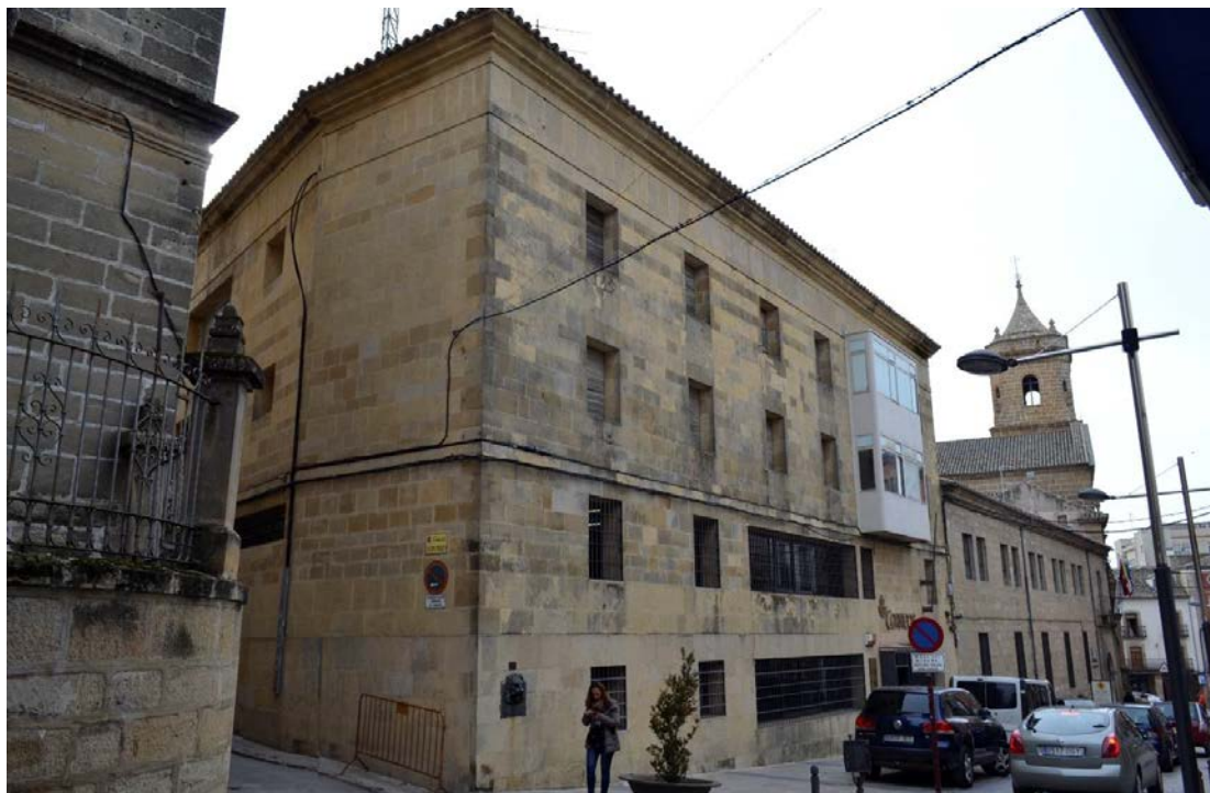
Fig.1 Edificio de Correos de Úbeda, fachada principal.
