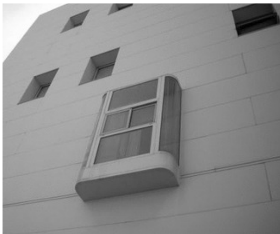
Figura 9: Fachada de chapa “pesa” (Edificio Correos León) Fuente: Fundación Alejandro de la Sota
