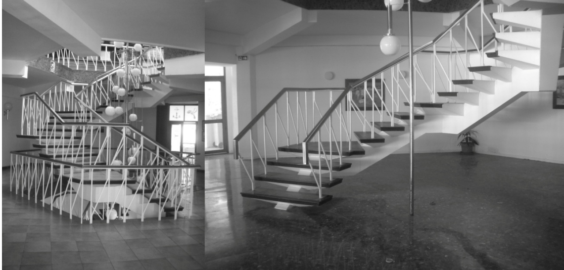
Fig.5. Escalera desarrollada por tramos siguiendo perímetro hexagonal de hueco central del edificio. Fotografía de la autora, estado actual.
