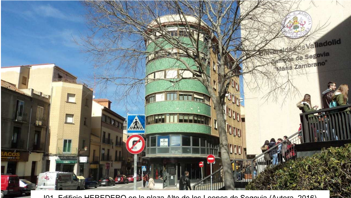
I01. Edificio HEREDERO en la plaza Alto de los Leones de Segovia (Autora, 2016)
