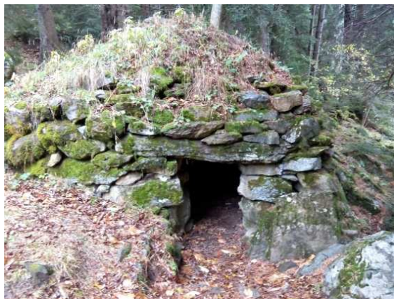
Caseta de falsa cúpula. Canfranc 8
