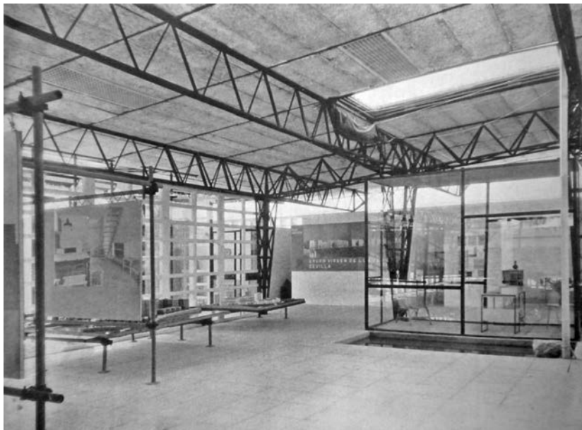
FIG 5. Interior del Pabellón de la Obra Sindical del Hogar. Hogar y Arquitectura, nº 4, Mayo-Junio 1956.
