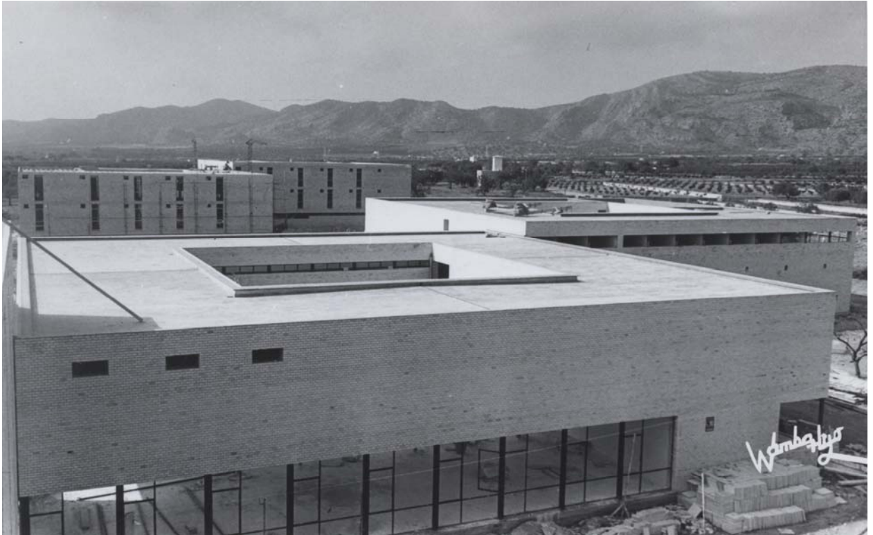
(Fig. 6) Seminario de Castellón. Pabellón de comedores en construcción. Legado Luis Cubillo. Servicio Histórico COAM
