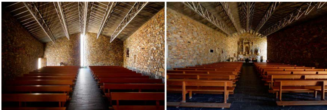
Fig 9. Vista del templo terminado desde el interior. Fotos Alex del Río.
