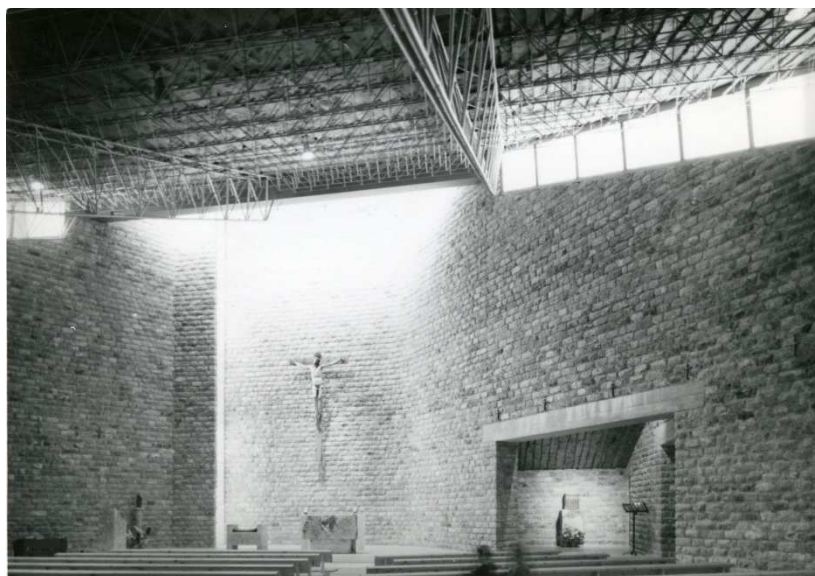
Iglesia de Canfranc. Vista general del presbiterio, con doble iluminación cenital y lateral a Sur; y de la nave, con dos huecos longitudinales en la parte superior de los muros. (Fundación Miguel Fisac)
