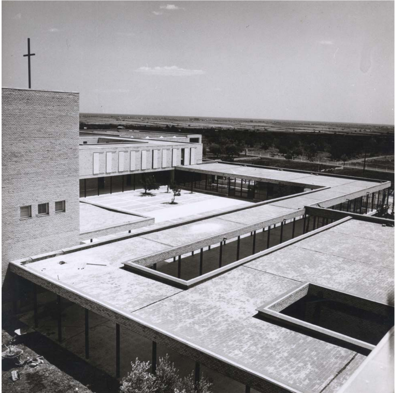
(Fig. 4) Seminario de Castellón. Patio de acceso. Legado Luis Cubillo. Servicio Histórico COAM
