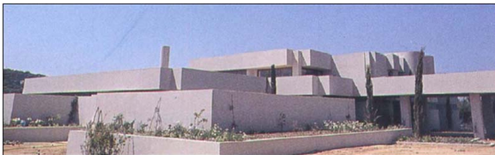
Fig. 2 .Casa Lladó. Alcaidesa. San Roque (Cádiz). Javier Carvajal. Arquitecto. 1991
