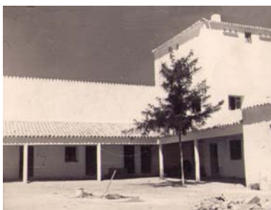
(Fig. 3) Patio de Caserío en finca de labor. Cuenca
