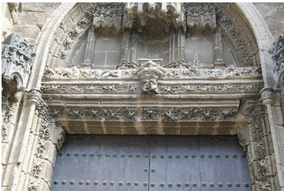
Ilustración 2. Dintel de la puerta
