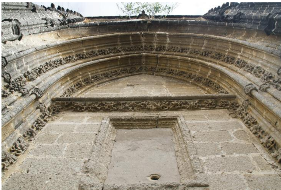
Ilustración 21. Puerta occidental de San Mateo. Jerez
