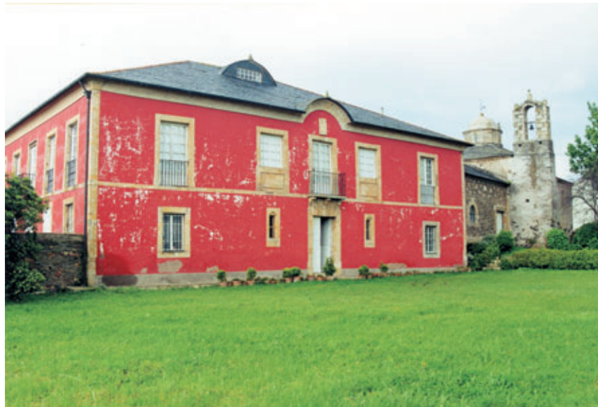
Estado actual de la casa de Andrés, con la iglesia de Santo Domingo.
