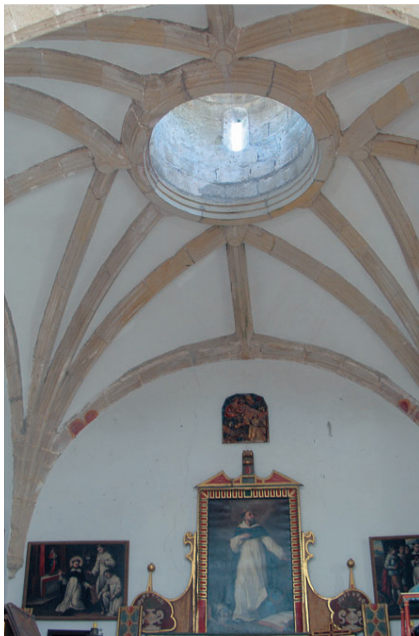
Bóveda de nervios y linterna de la capilla mayor de la iglesia de Santo Domingo (Andés).
