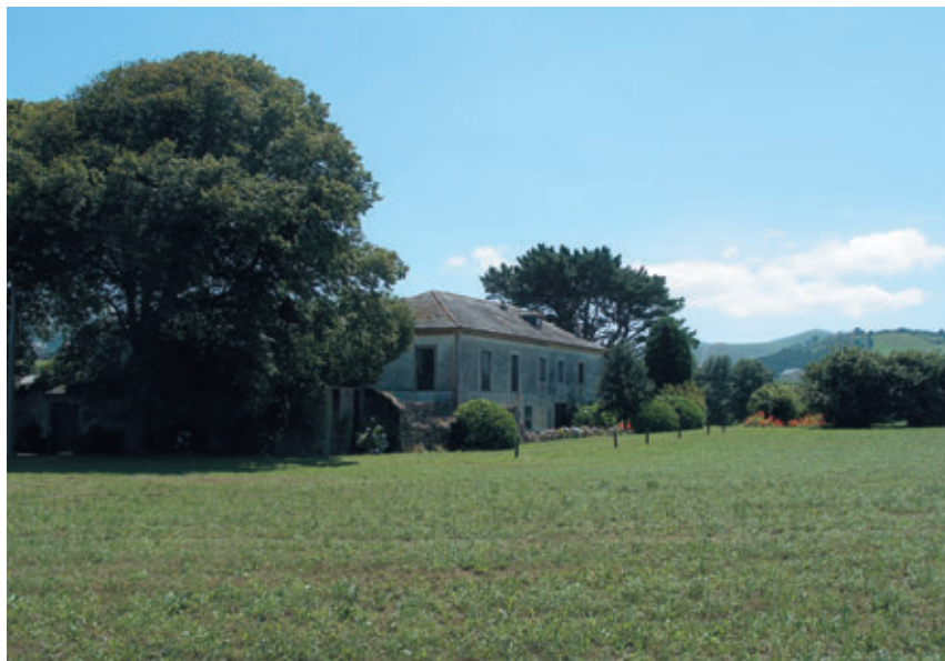
Vista parcial de la casa de Taborcias (fachada sur).
