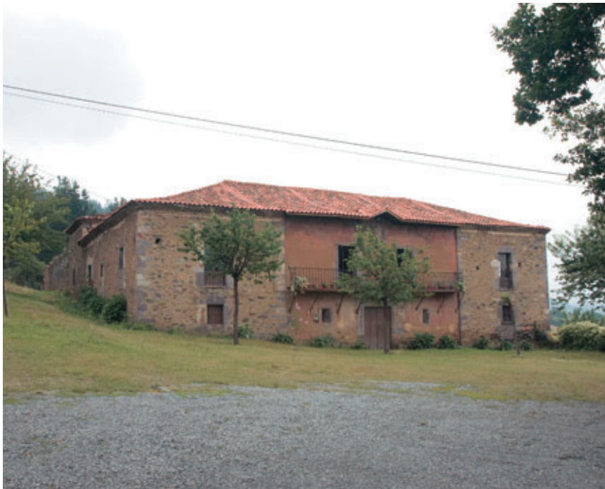
Fachada principal de la casa de Jarceley
